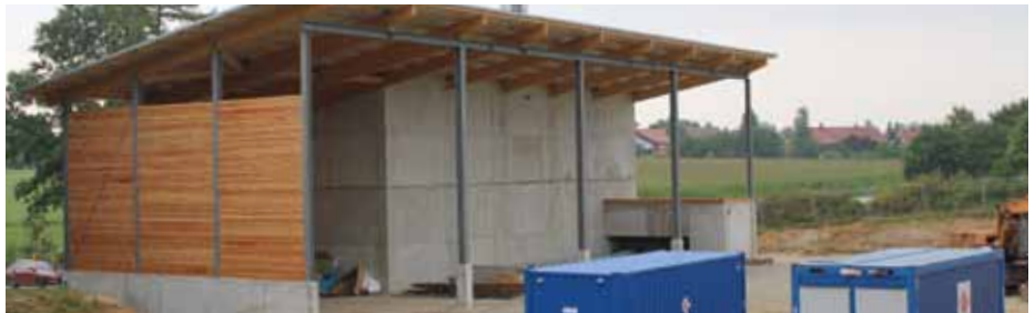
Das Heizwerk Engelsberg kurz vor der Fertigstellung im September 2012.
